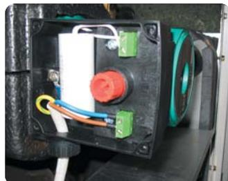
**Les pompes à chaleur Airwell sont équipées de base d'un interrupteur de proximité faisant office de bornier d'alimentation générale. À noter la possibilité de cadenasser cet interrupteur.**
